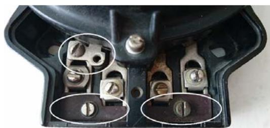
Рис. 3. Хищение электроэнергии с помощью самодельного шунта
