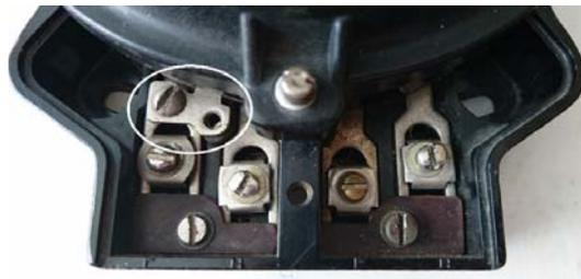
Рис. 2. Отсутствие на счетчике крышки клеммной колодки или пломбы
